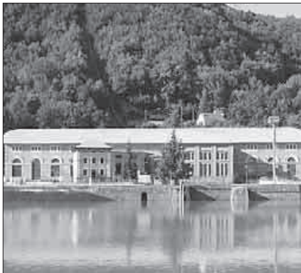
La centrale Enel di Ligonchio
